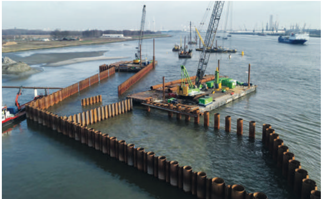
Figuur 2 – Heiwerkzaamheden kistdammen toerit Noordzijde.
