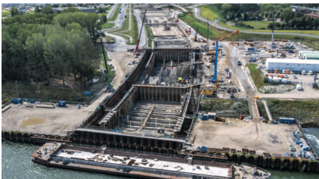
Figuur 1 – Kistdammen en toerit Noordzijde (boven) en Zuidzijde (onder).
