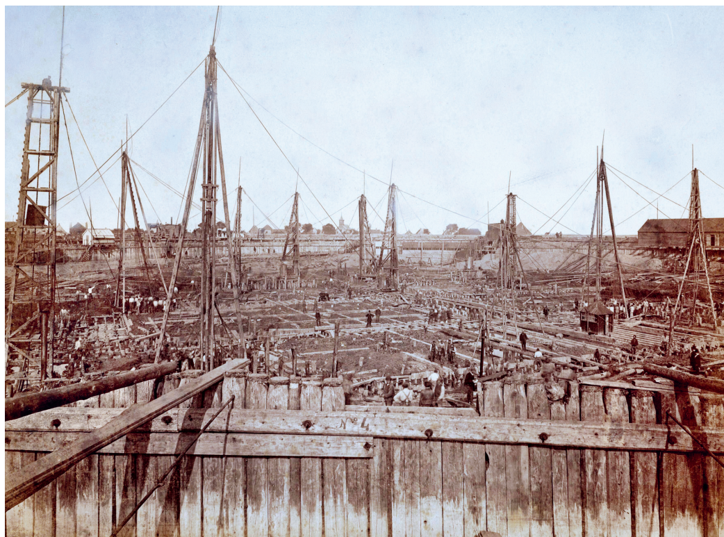
Figuur 3 – Foto van de Oranjesluizen in Amsterdam-Noord in aanleg, september 1869. Aanzicht in de kistdam, met heiwerk met 3 gewone en 7 stoomheien, aanleg van fundering, gezien uit het zuidwesten. Nummer 22 in een reeks foto's die Pieter Oosterhuis maakte van de aanleg van het Noordzeekanaal. P.D., Archief Amsterdam, 010017000005, (Collectie A.M.J. Hendrichs)
