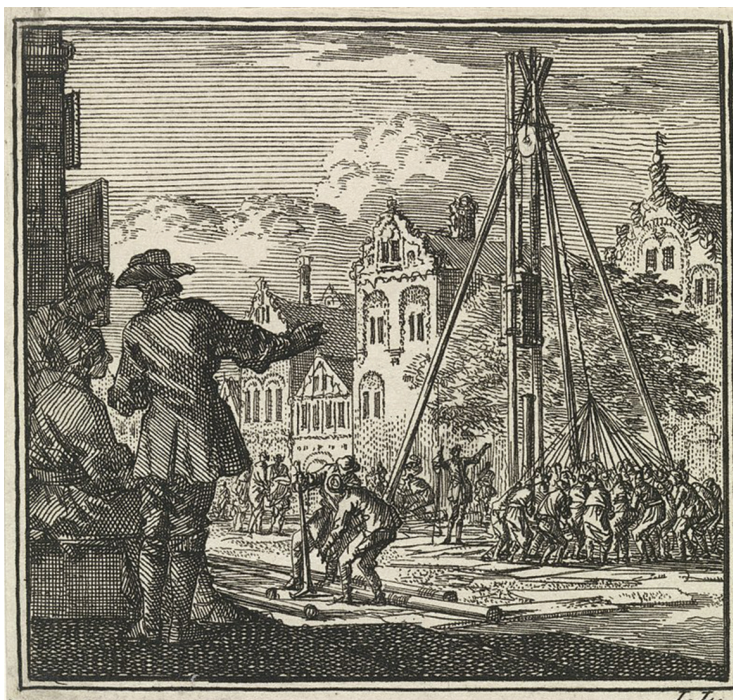
Figuur 2 – Enkele mannen kijken hoe een paal met een heiblok in de grond geslagen wordt. Prent van Jan Luyken, getiteld 'De Hey'. Boekillustratie uit De Bykorf des Gemoeds (1711), 346. P.D., Wikimedia, Objectnummer: RP-P-OB-45.623
