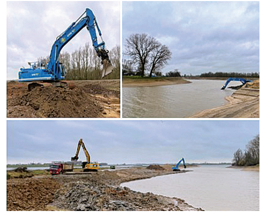
Figuur 4 – Winning van gebiedseigen grond voor dijkversterking Gorinchem-Waardenburg ter plaatse van uiterwaardvergraving binnen het projectgebied.
