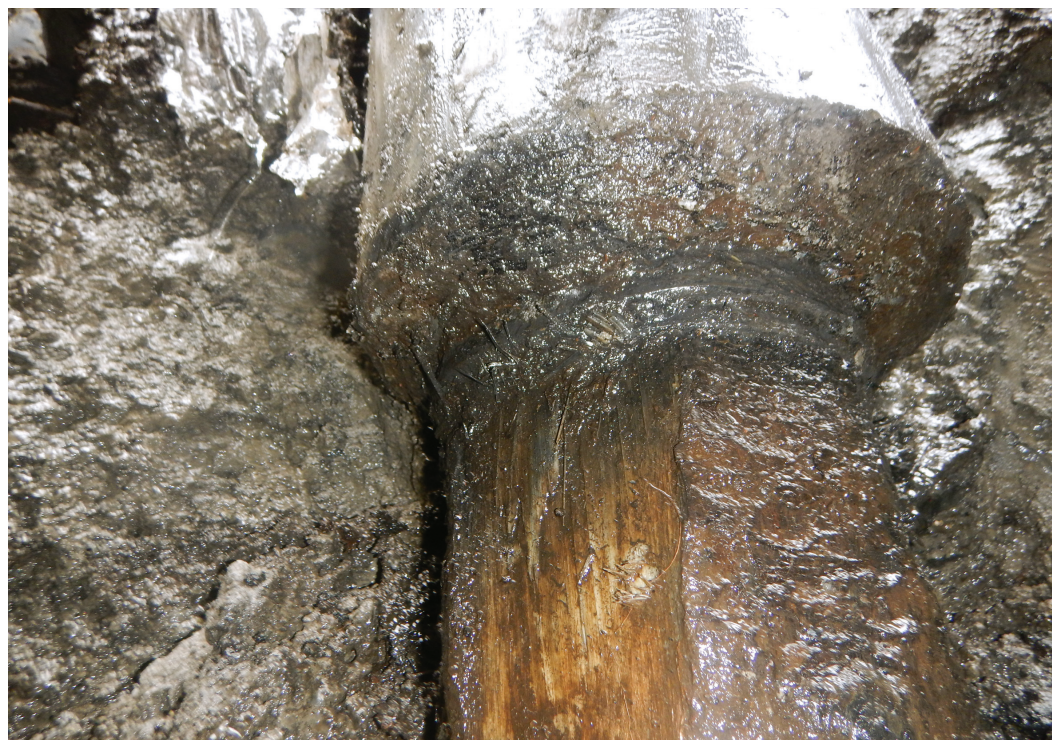
Figuur 1 – Verbinding paal met oplanger.
